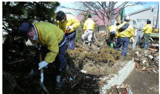
野田村役場がれき撤去作業
