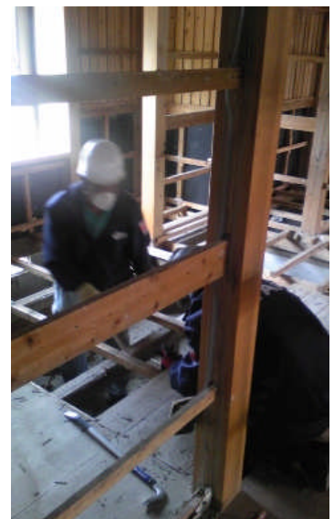
床板はがして泥出し
